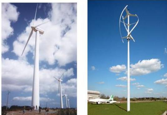
Fig.1. Types d'éolienne
